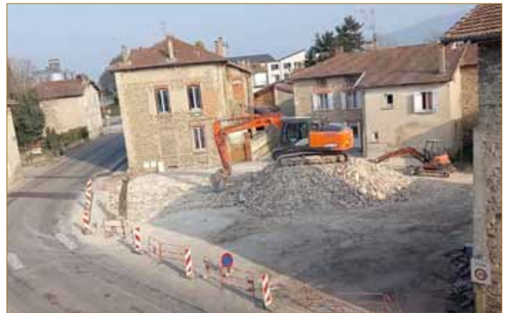
Démolition de la maison de Claire PAYEN
