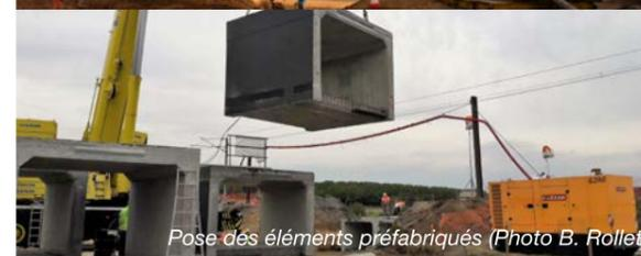
Pose des éléments préfabriqués (Photo B. Rollet)
