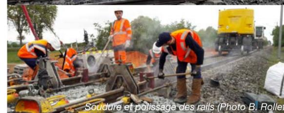
Soudure et polissage des rails (Photo B. Rollet)
